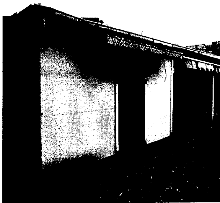
Bâtiment devant être détruit
